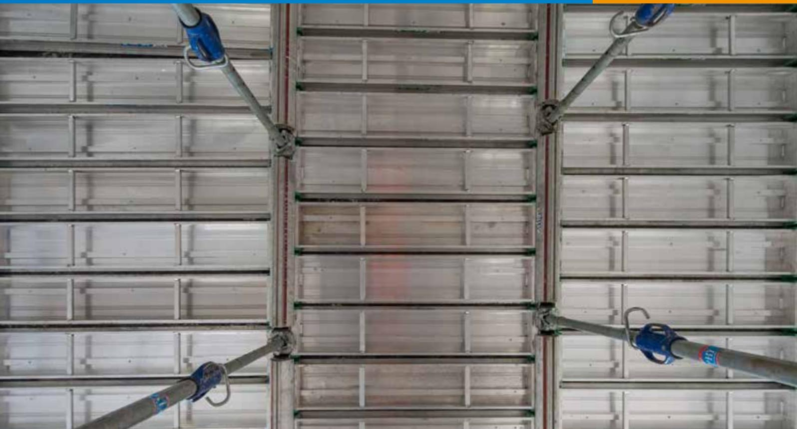
TopDalle Eco, die neueste Alphi-Innovation für Systemschalungen im Wohnungsbau, ist in Sachen Sicherheit und Produktivität unübertroffen. Seine ganzflächigen Paneele bilden eine echte Arbeitsplattform, die stabil und sicher ist. Die Monteure arbeiten unter sicheren Bedingungen und mit höherer Produktivität.
